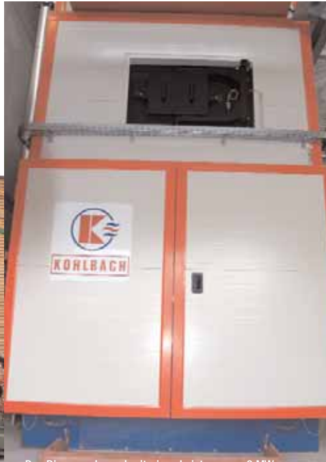
Der Biomassekessel mit einer Leistung von 2 MW vom Kesselspezialisten Kohlbach
