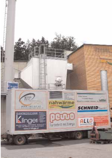
Der mobile Heizcontainer als zusätzliche Ausfallsreserve für die Heizwerke in Gleinstätten und Wies
