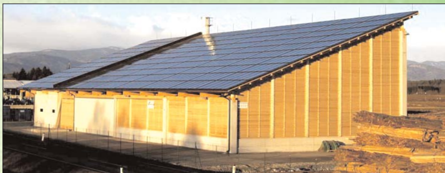
Heizwerk Gleinstätten mit kombinierter Wärmeerzeugung - Biomasse und Solar inklusive integrierter Hackgutlogistik Foto: Nahwärme Gleinstätten GmbH
