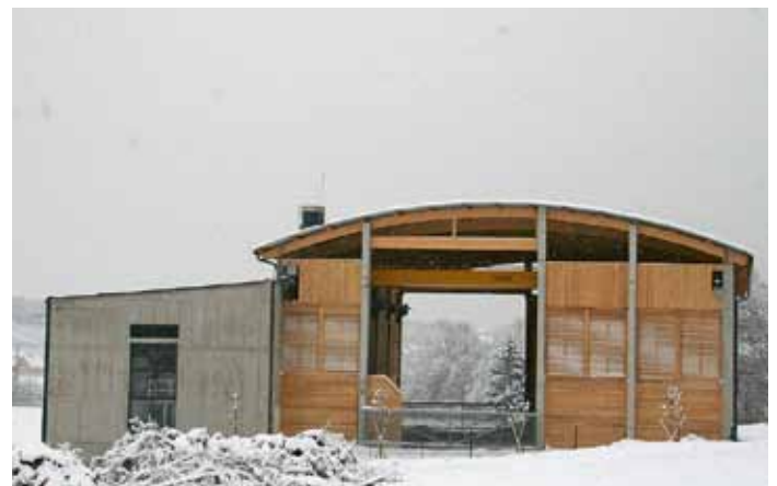
Heizwerk Gamlitz: Seit 12. Oktober 2009 werden 75 Abnehmer mit umweltfreundlicher Wärme beliefert
